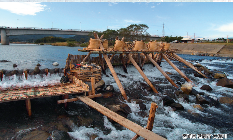
宮崎県延岡市大瀬川
