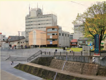
本明川に整備された駅前公園から続く護岸
